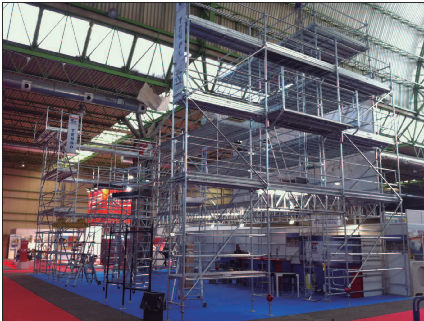
Vista del stand montado por ANDAMIOS TENDO en Smopyc 2011.
